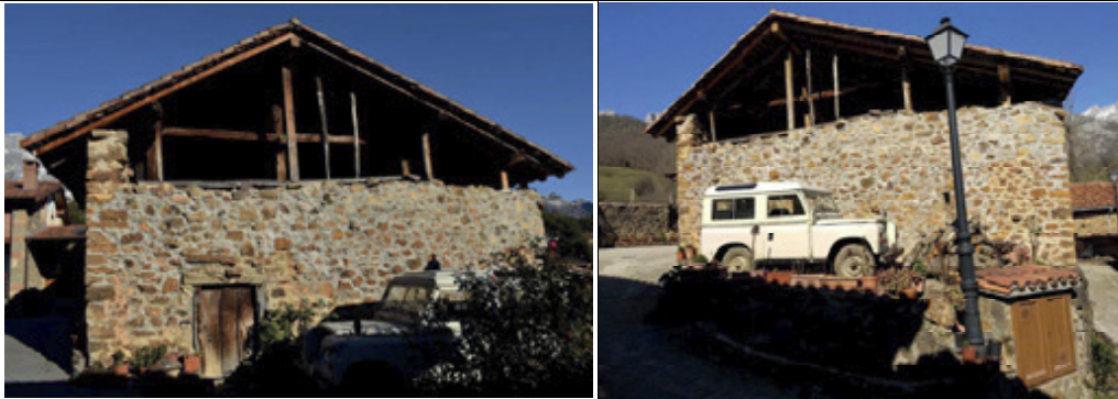
Fachada sur (dos huecos, uno grande en madera y uno pequeño con sillar) y el cierre de parcela con armario contador.
