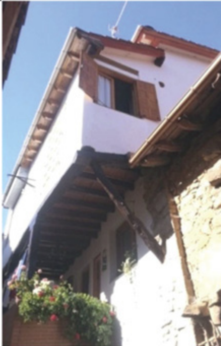
Vista inferior de la balconada de planta alta (con el jабalcón, y la ventana en el lateral este)
