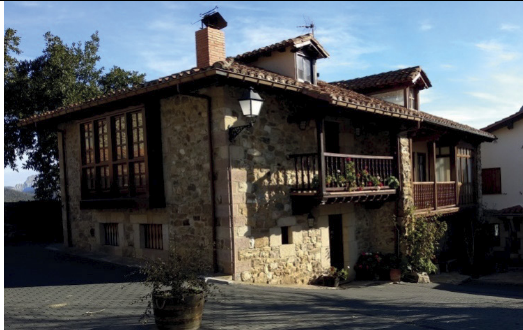
Vista de las fachadas suroeste y noroeste
