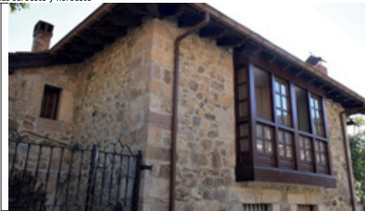
Vista de la fachada norte
