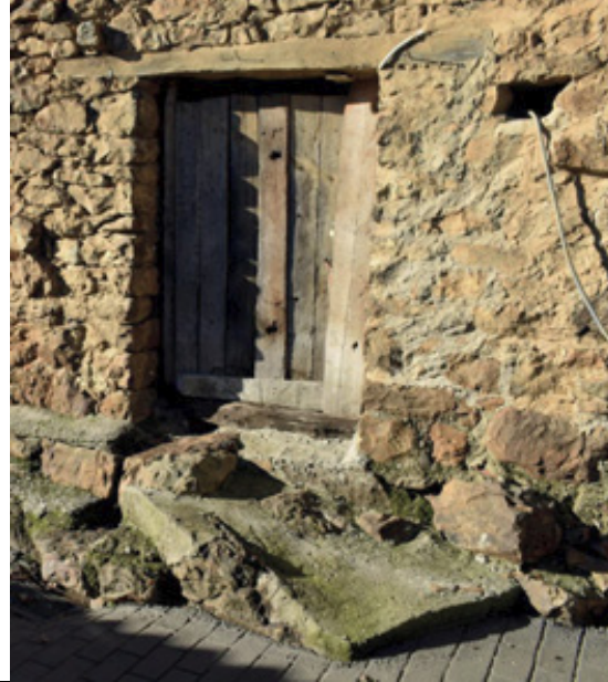
Fachada este (detalle del acceso)
