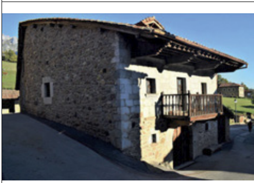
Fachada oeste (1ª parte norte)
