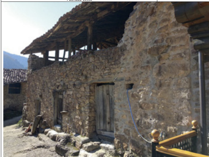
Fachada este (continua con ficha 40)
