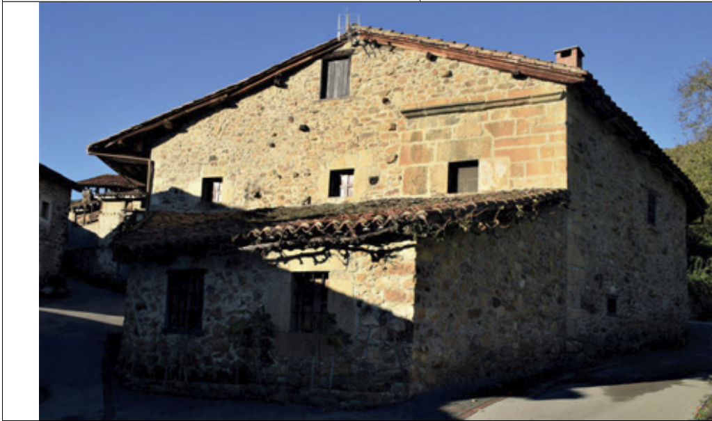
Fachada este con huecos en piedra (en diferente tipología) y cuerpo bajo adosado
