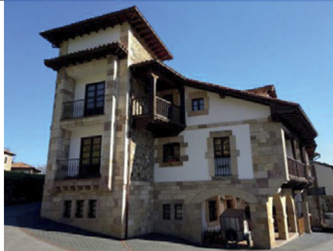
Vista de fachada oeste y sur parcialmente
