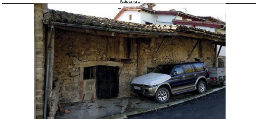
Fachada norte de esta edificación en primer plano
