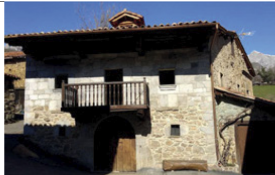
Fachada oeste (2ª parte sur) y fachada sur
