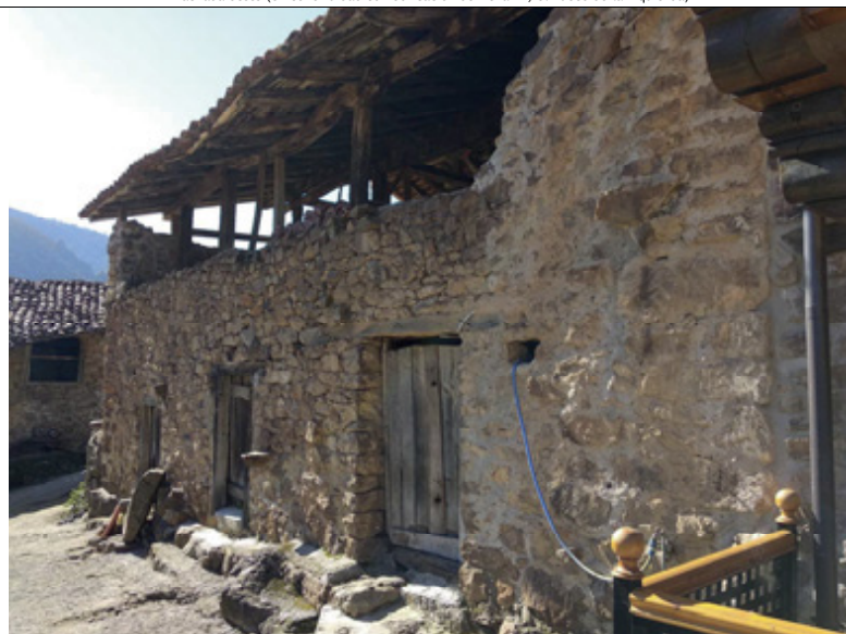
Fachada este (en continuidad con edificación de ficha 42, en primer plano)
