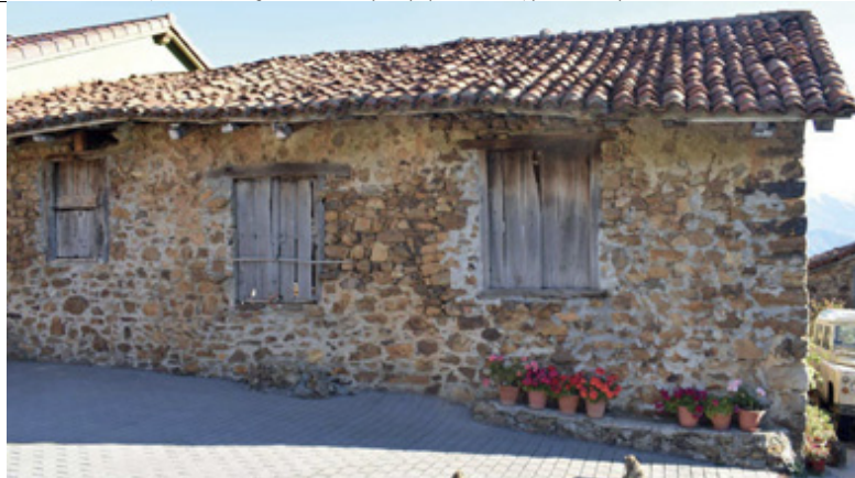
Fachada oeste (en continuidad con edificación de ficha 42, el hueco de la izquierda)
