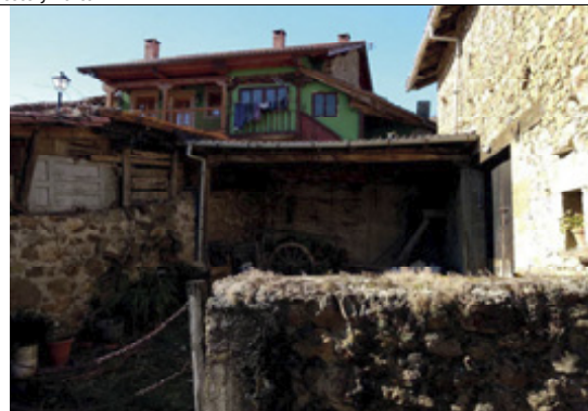
Tejavana adosada al sur de la edificación.
