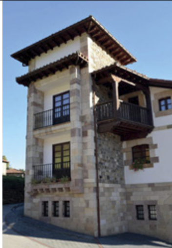
Torre en primer plano (fachada oeste)
