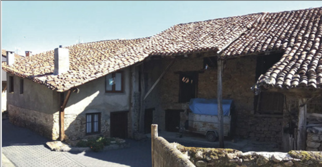
Vista de conjunto de las corralas de 29, 30 y 32 (suroeste)
